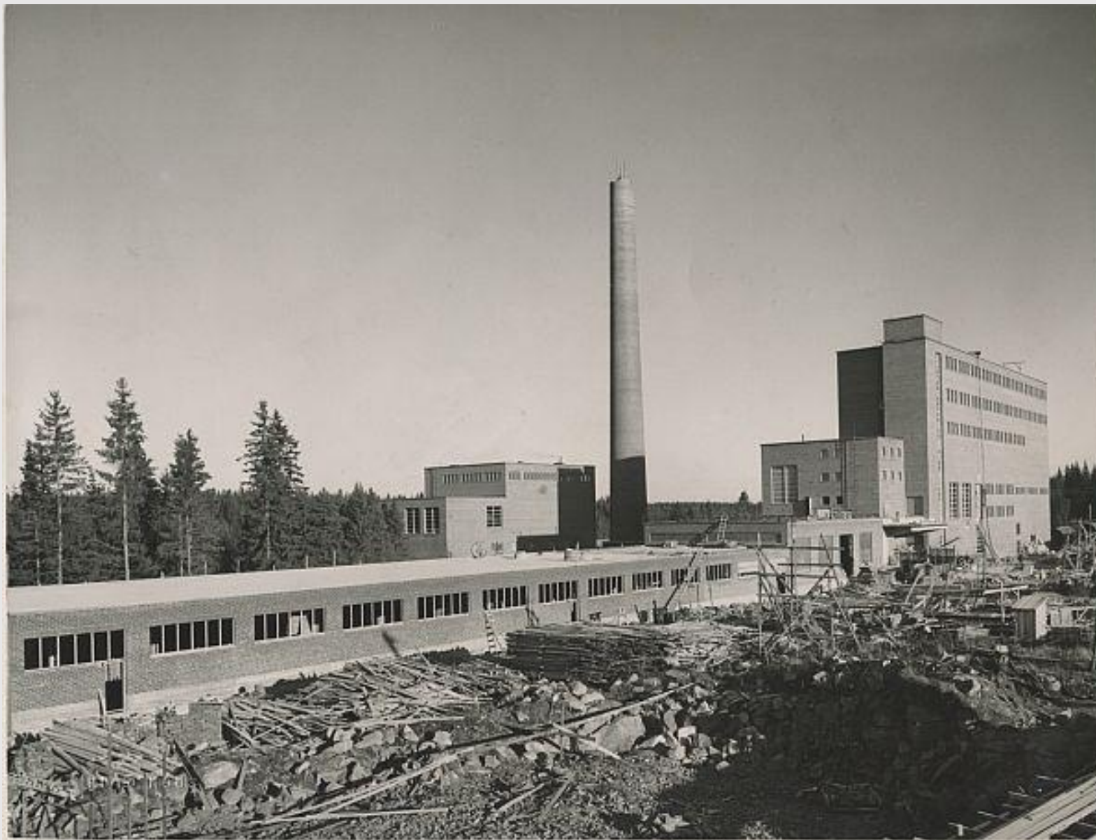
Voimalaitos ja sen piippu. Takana oikealla viskoositehdas. Edessä kehrulinja, jälkikäsittely ja kuivaus.
