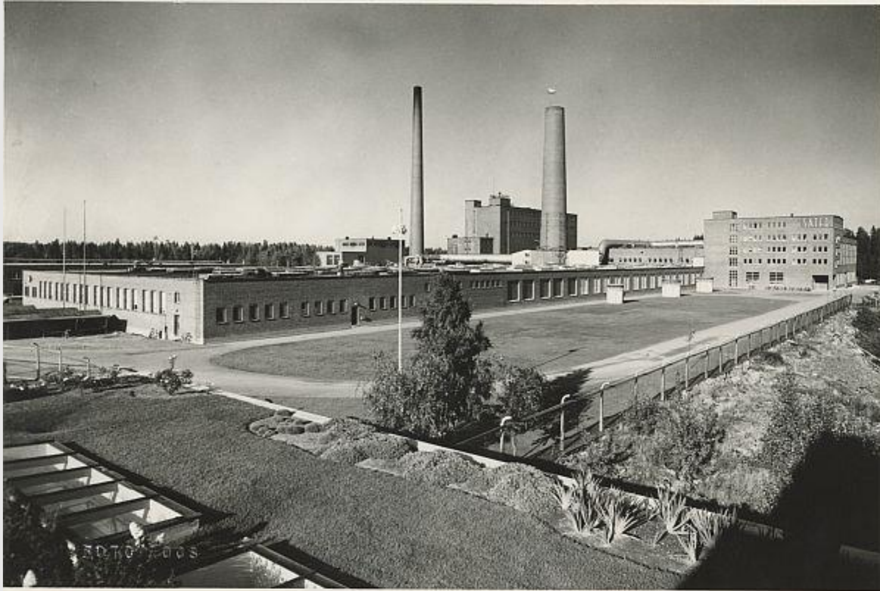
Kuvan etualalla hallintorakennuksen matala osa ja sen kattoikkunat. Vasemmalla raionsilkkit tehdas, jonka takana ohuempi voimalaitoksen piippu ja paksumpi kaasupiippu. Piippujen välissä viskoositehdas, oikeassa reunassa teknillinen konttori.
